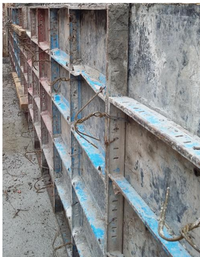
Fig. 4: Apuntalamiento de los encofrados
