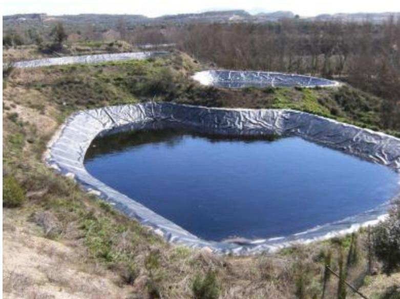
**Figura 21.** Balsas de evaporación impermeabilizadas.
