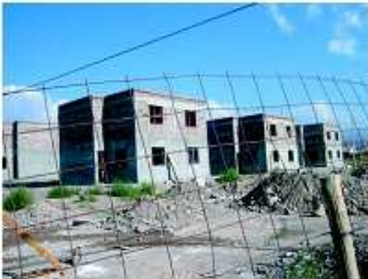
Duplex en construcción
