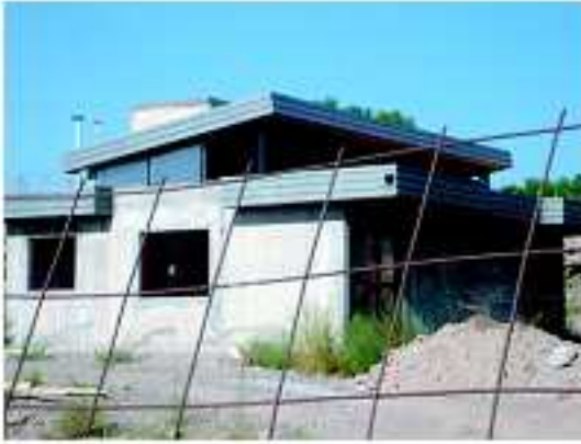
SUM en construcción
