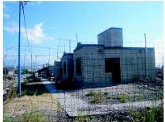
Bº en construcción
