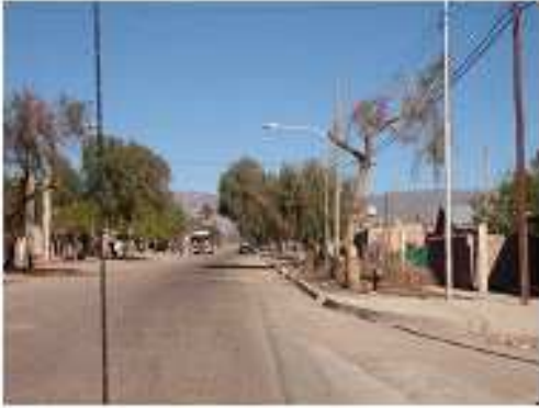
Calle Principal Acceso 1
