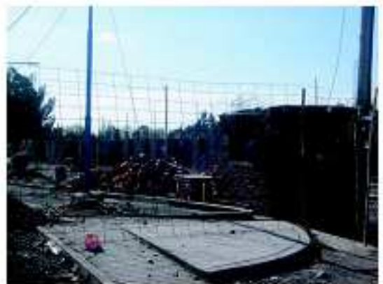
En construcción Bº La Esperanza III
