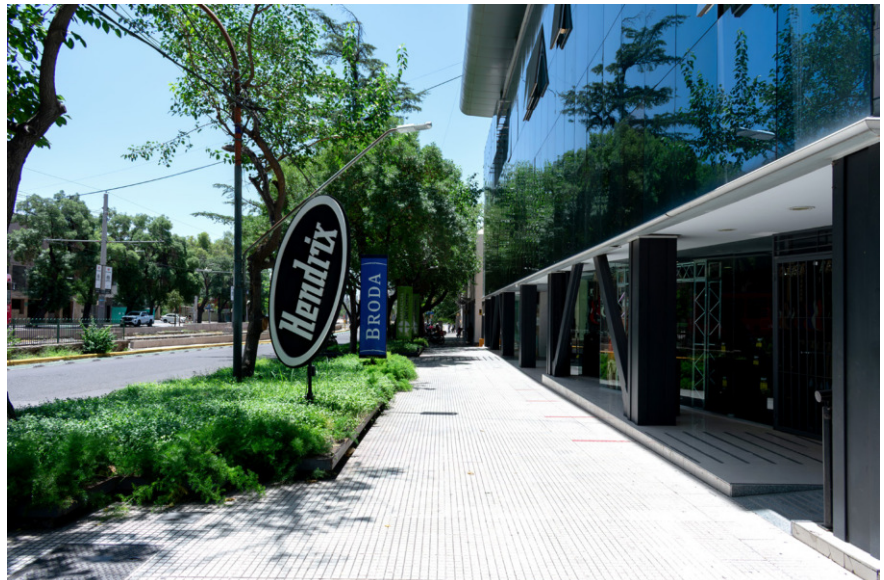
Edificio Libertadores (1992) y Edificio Angulo (2000) (Fuente: Pablo Llorca, 2025).
