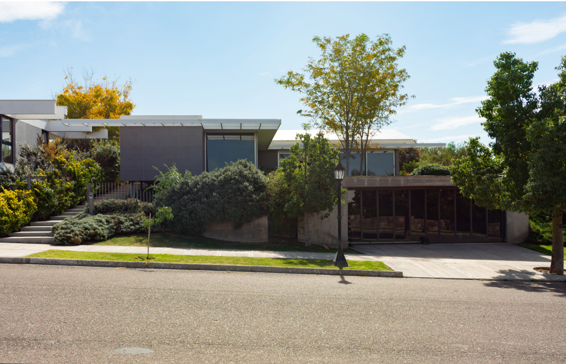
Fachada principal (Fuente: Pablo Llorca, 2026).
