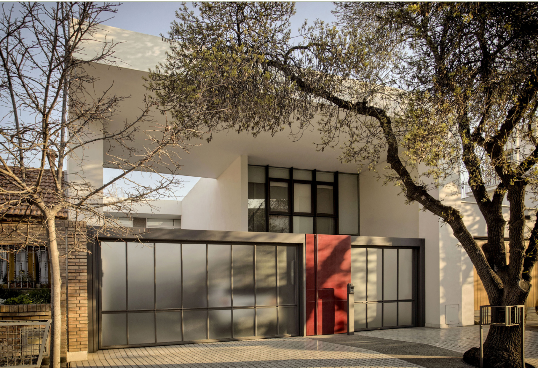
Fachada principal (Fuente: Estudio Sardi).
