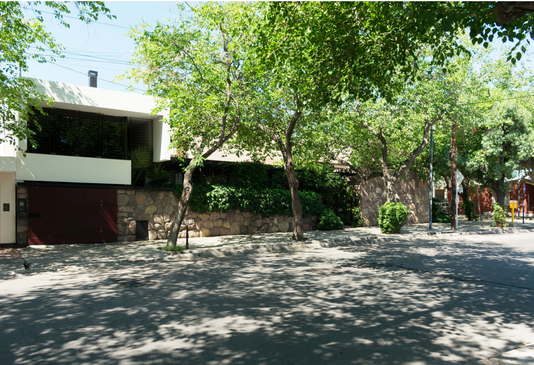
Fachada norte. La pendiente descendiente de la calle Sobremonte explica la operación del proyecto respecto de sus desniveles (Fuente: Pablo Llorca, 2025).
