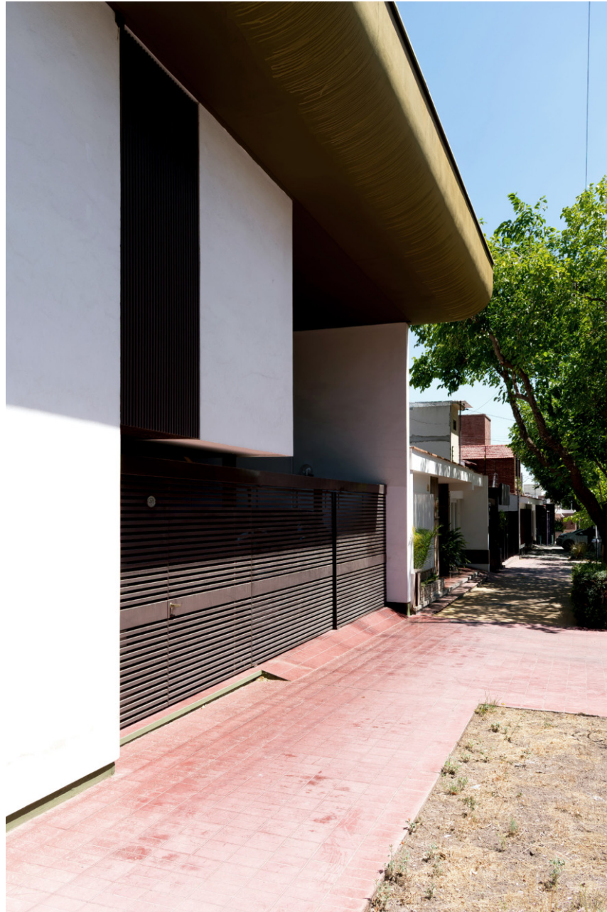
Vista peatonal hacia el norte (Fuente: Pablo Llorca, 2026).
