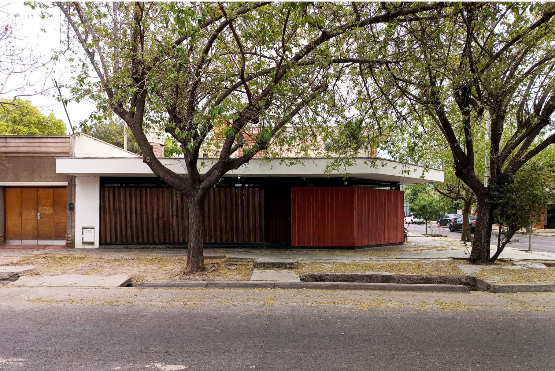
Fachada este (Fuente: Pablo Llorca, 2024).
