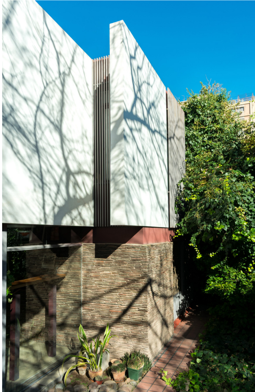
Encuentro de planos de fachada norte hacia el patio (Fuente: Pablo Llorca, 2025).
