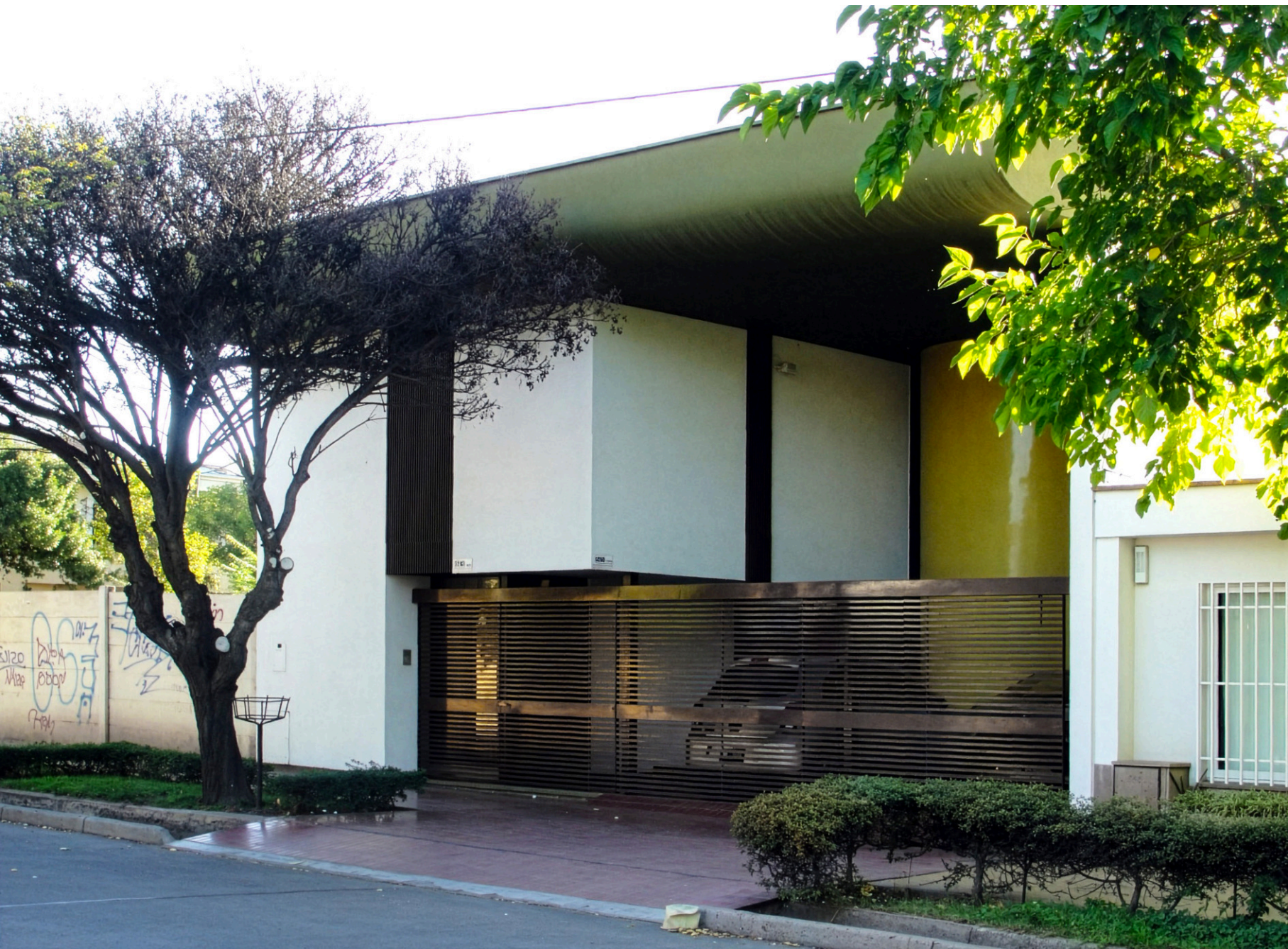
Fachada principal (Fuente: Estudio Sardi).
