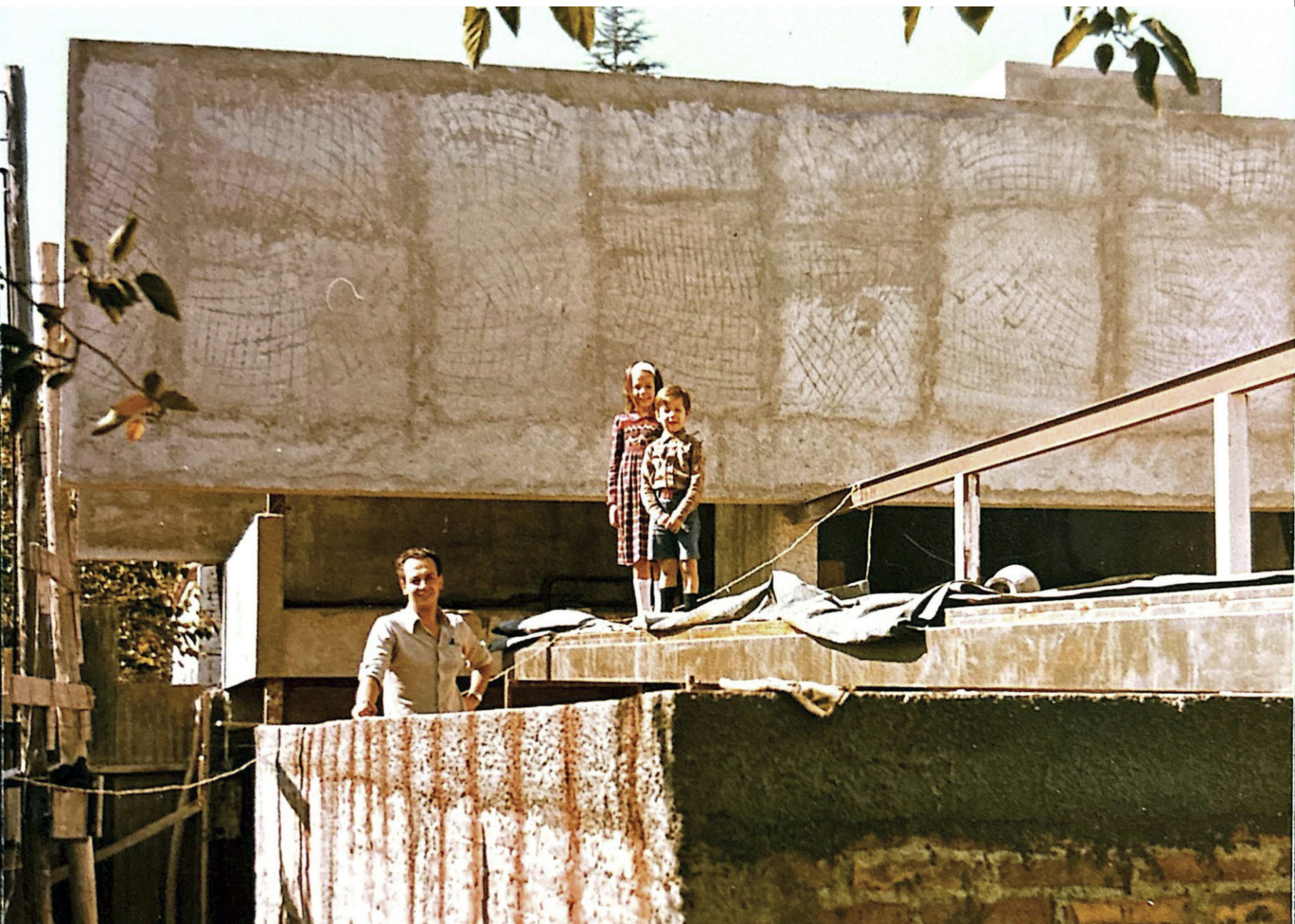
Rodolfo Sardi y sus hijos, Maria Elena y Rodolfo, durante la construcción de su casa (Fuente: Estudio Sardi).
