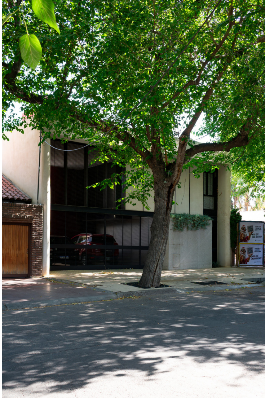
Fachada principal (Fuente: Pablo Llorca, 2025).
