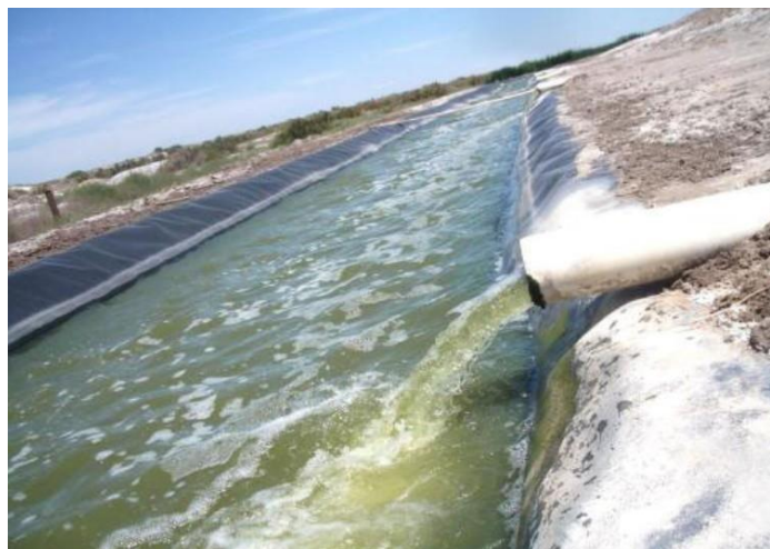
Ilustración 5: Planta Campo Espejo. Canal receptor de aguas tratadas.
