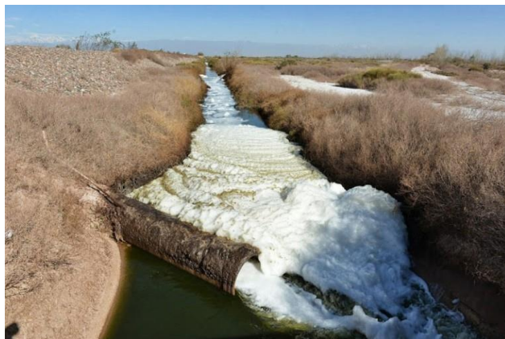
Ilustración 8: El Paramillo. Punto de vuelco al canal de fuga que desemboca al río.
