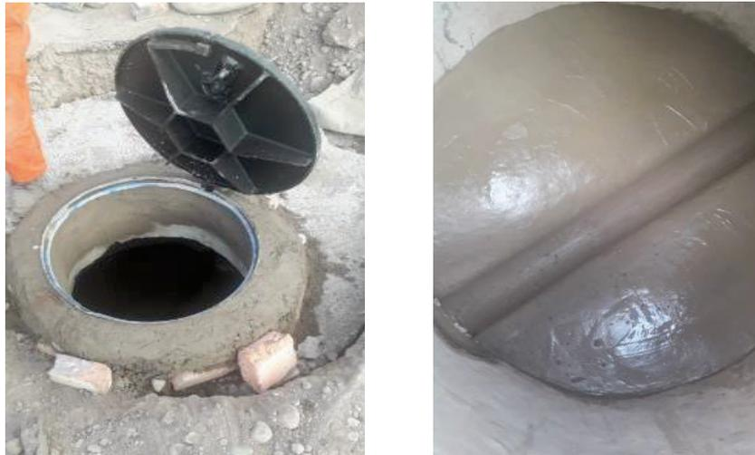
Figura N° 11: Tapa de Hierro Fundido – Cojinete.
