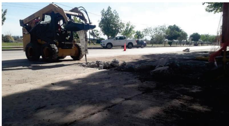
Figura N°5: Rotura de pavimento existente mediante martillo neumático.
