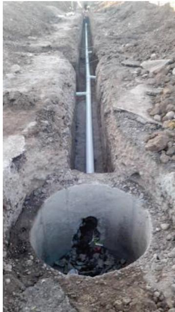
Figura N°15: Vinculación de Red con Boca de Registro.
