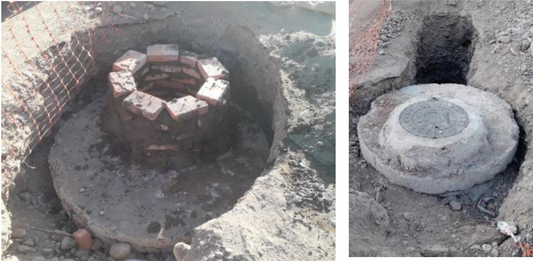
Figura N° 10: Boca de registro con brocal – Boca de registro sin brocal.
