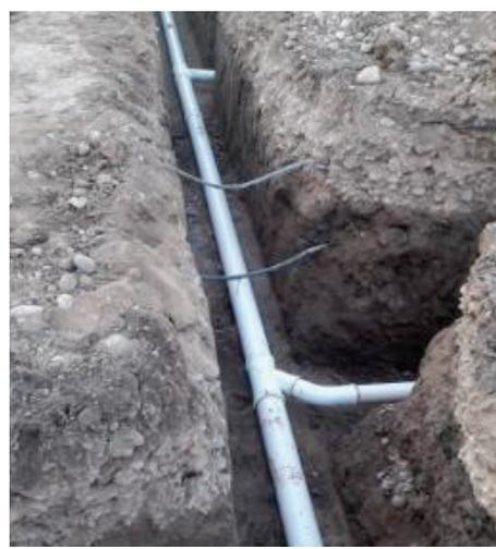
Figura N°14: Colocación de instalación domiciliaria.
