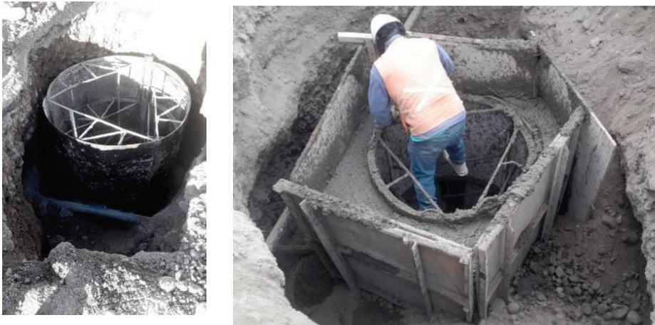
Figura N°9: Encofrado y llenado de boca de registro.
