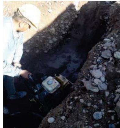
Figura N°18: Compactación manual-mecánica.
