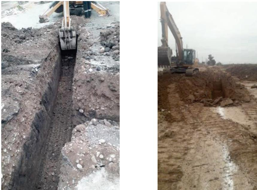
Figura N°6: Excavación mediante retroexcavadora y Excavadora.
