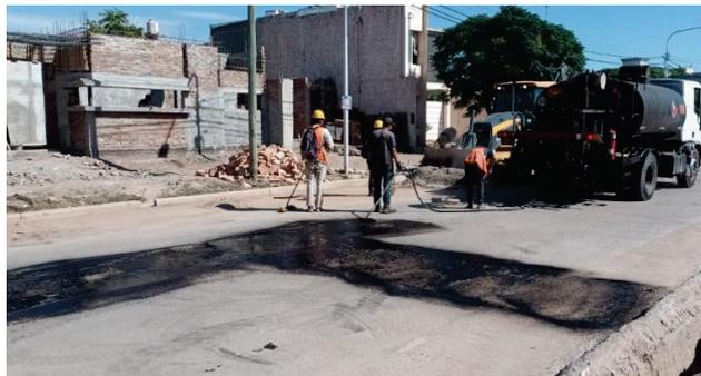
Figura N°19: Aplicación riego de liga.
