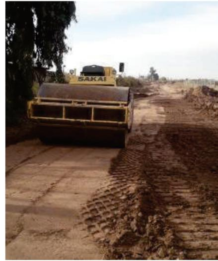
Figura N°17: Compactación mecánica.
