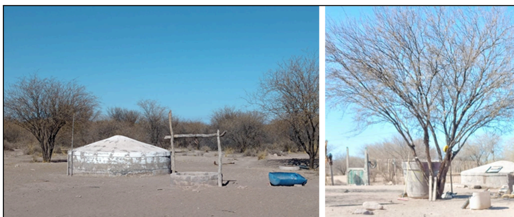
Figura 11: Cisternas de placas y pozo calzado con anillos de cemento.
