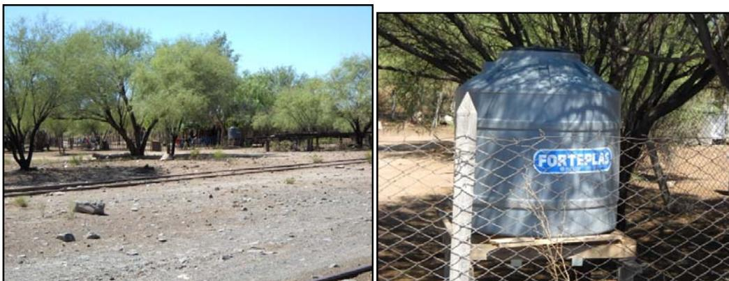
*Foto 17: Sistema de almacenamiento agua potable. Izquierda: Puesto con tanque de almacenamiento de agua potable, en poblado de San José. Derecha: Tanque de almacenamiento de agua potable de 1100 litros. Fuente: Archivo de Lorena Sales, Mendoza, 2009.*
