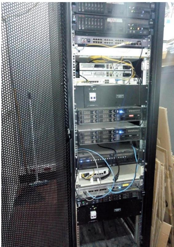
Para lograr una energía ininterrumpida también se poseen 2 UPS destinados a los servidores y uno por cada PC ubicada en la oficina central. Estos otorgan un lapso de 15 minutos para guardar los archivos abiertos ante un corte de energía.
