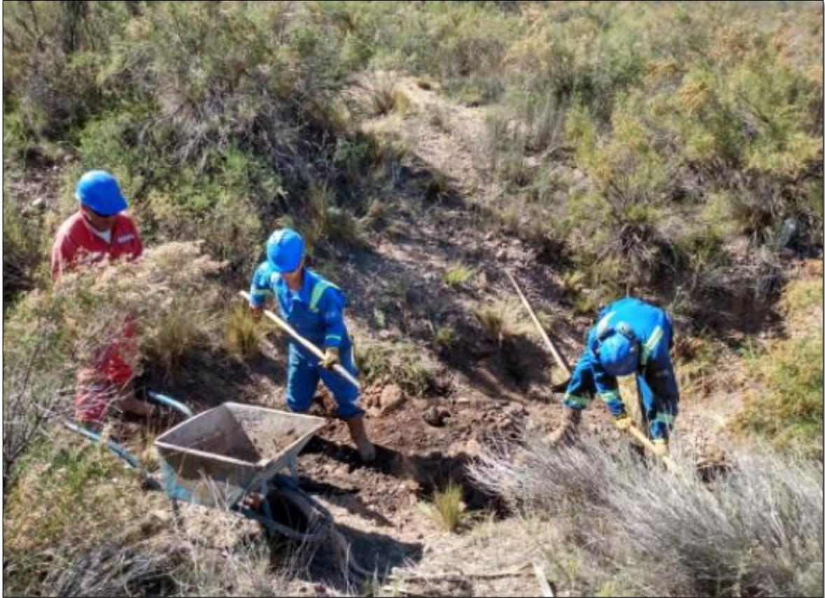
**Figura 10.** Retiro manual de costras de hidrocarburo. Fuente: Fundación Cricyt
