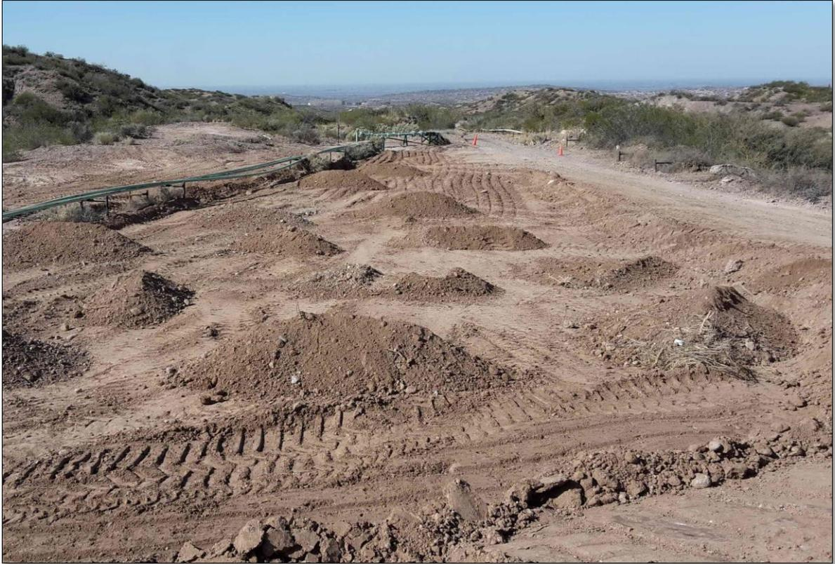
**Figura 11.** Relleno y formación de montículos. Fuente: Fundación Cricyt.
