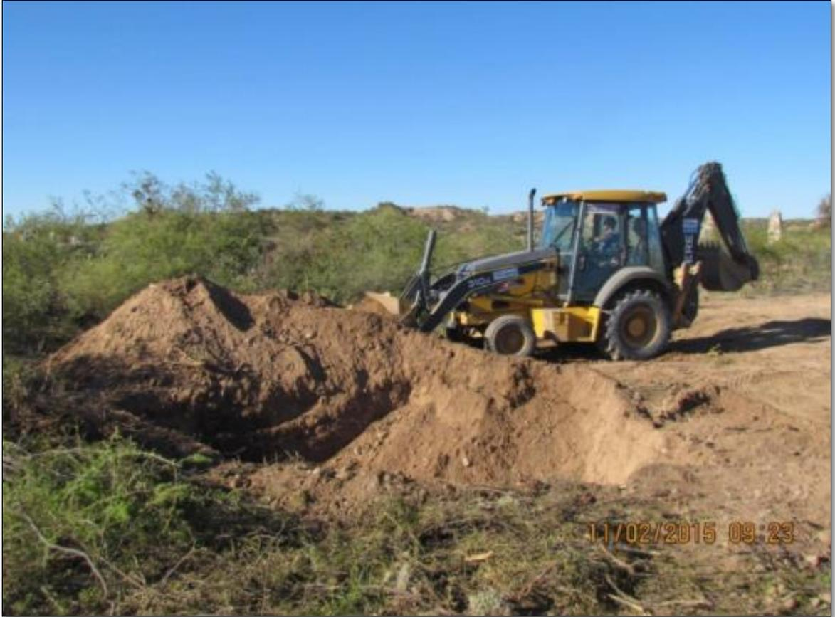
**Figura 6.** Acopio de material limpio. Fuente: Fundación Cricyt
