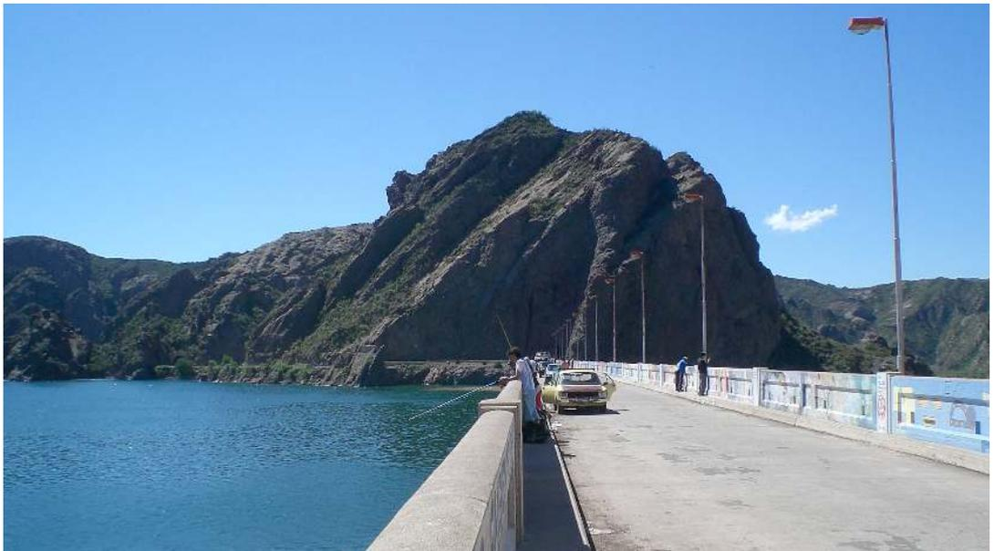
agua superficial y, en la distribución y disponibilidad de agua subterránea. El dique es una estructura de hormigón cuyas principales características son: 300 m de longitud, 115 m de altura máxima desde su fundación, 164 hm<sup>3</sup> de capacidad y 300 m<sup>3</sup>/s de capacidad de descarga. (Foto 107)
