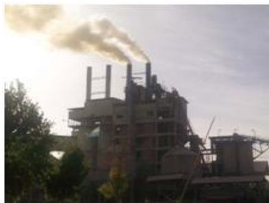
a) Emisión de gases por chimenea (Planta B)
