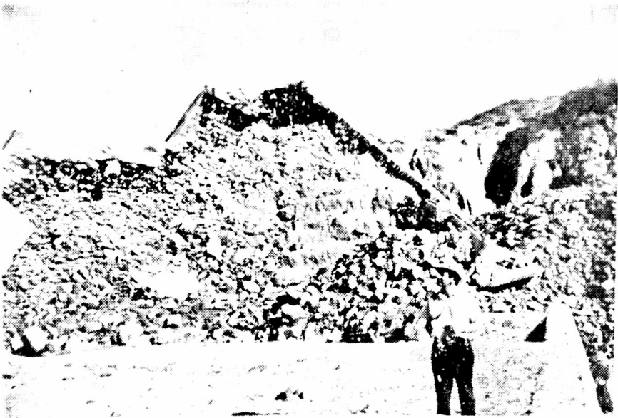
Fot. 2 — Detalle que ilustra la naturaleza del muro de contención y sus proporciones.
